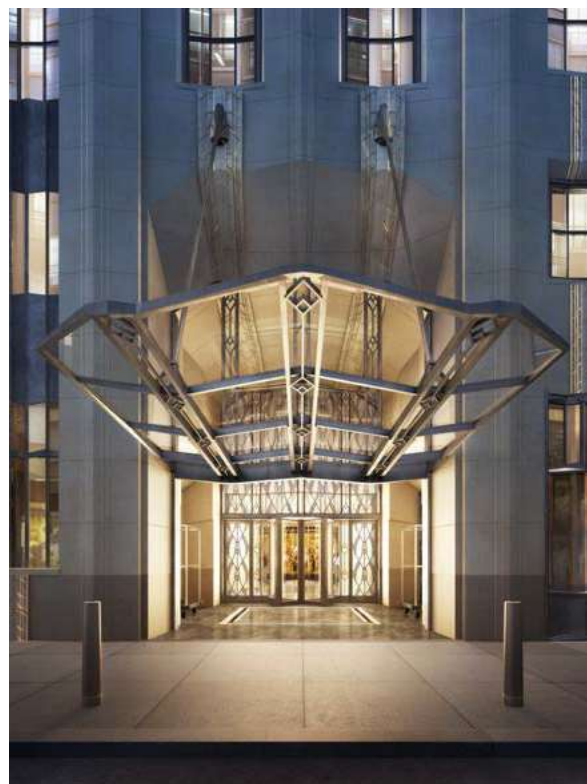
Art-Deco und einst das höchste Gebäude New Yorks: Das One-Wall-Street-Gebäude wird umfassend saniert.
