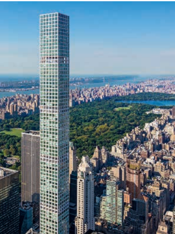
Starke Proportionen: Auf einer Grundfläche von 28 mal 28 Meter ragt das Gebäude 432 Park Avenue 89 Stockwerke in die Luft.
